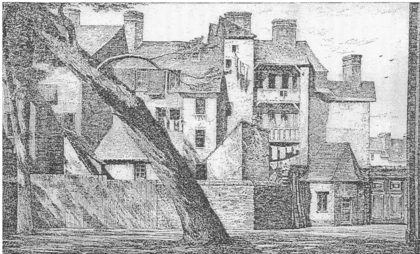
Les maisons de la rue du lycée vues de la cour d'entrée, au sud de Toussaints
