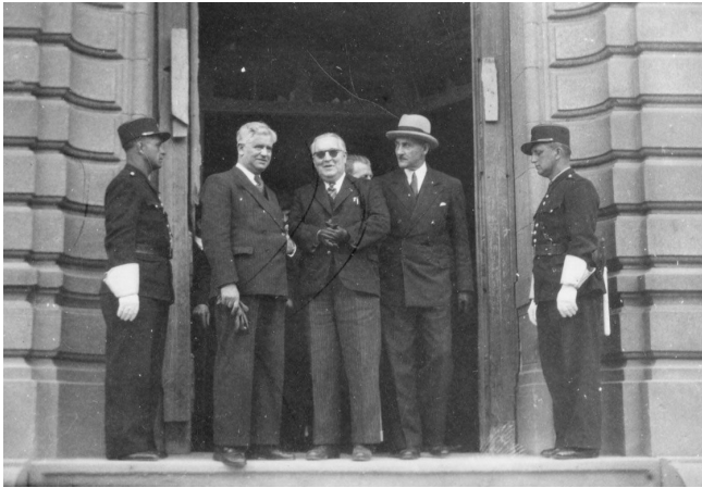
1947 • Le proviseur Fabre entre Edmond Naegelen, ministre de l'Instruction Publique, (à gauche) et le préfet Billecard en civil. Le lycée n'a pas encore de porte ; dans le hall des échafaudages.
